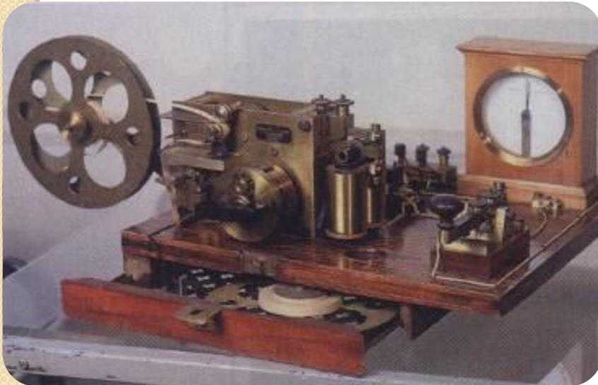
Телеграф – система связи для передачи сообщений при помощи электрических сигналов
